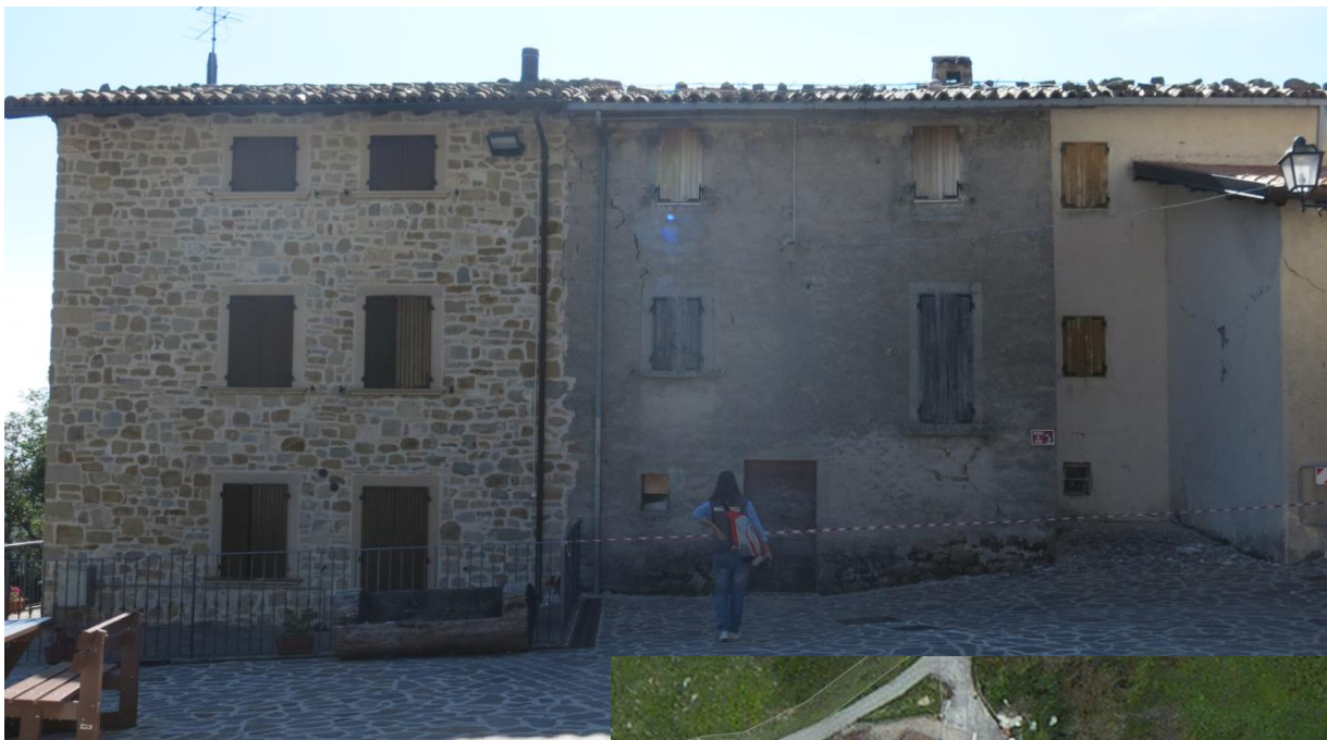
Rischio esterno su via di accesso indotto dai fabbricati circostanti
